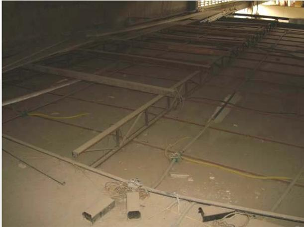
Figura IV. 50 - Condutores S/Forros PVC
