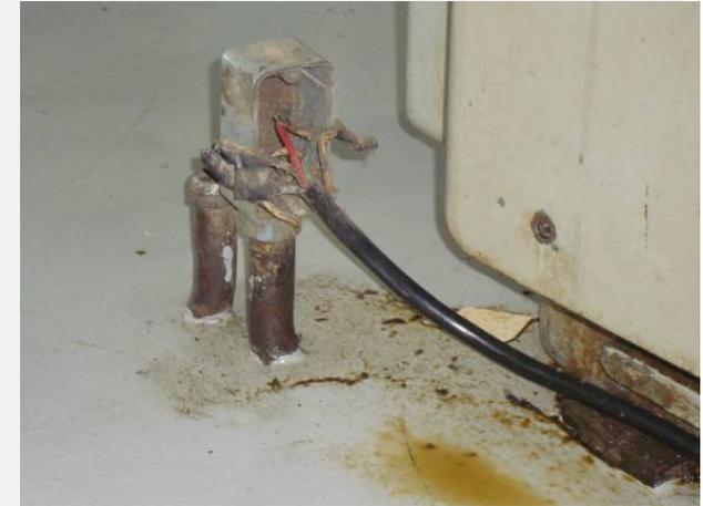
Figura IV. 54 - Ligações inadequadas
