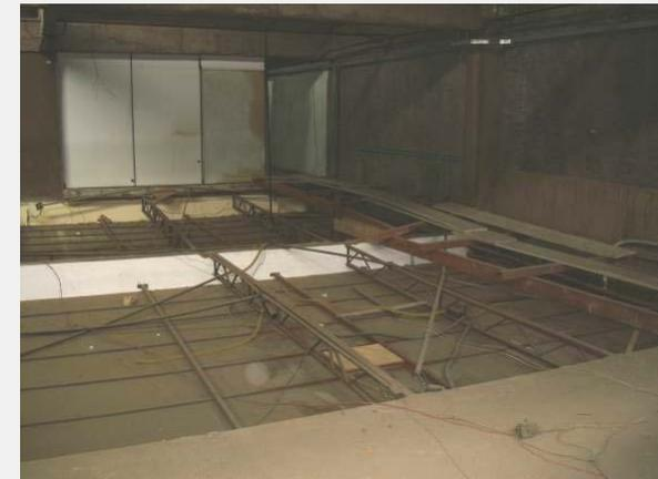
Figura IV. 82 - Circuitos Elétricos S/ Forros
