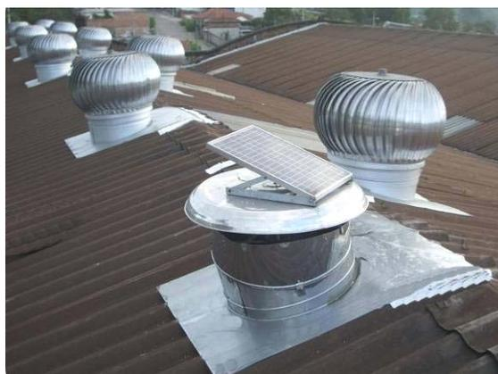
Figura V. 2 - Exaustores Eólicos e Solares
