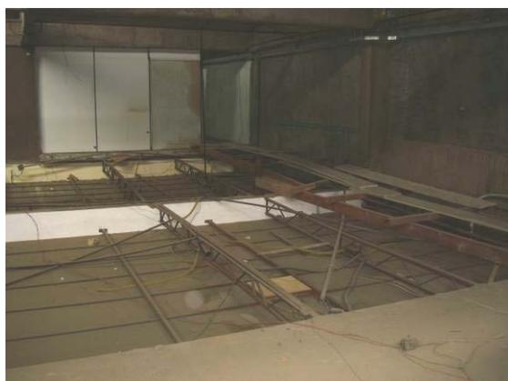
Figura IV. 82 - Circuitos Elétricos Sobre Forros
