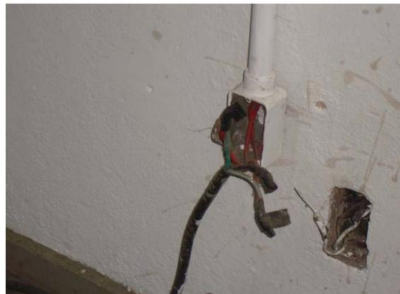
Figura IV. 53 - Condutores sem Isolamento
