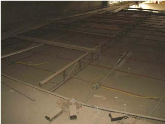
Figura IV. 50 - Condutores S/Forros PVC
