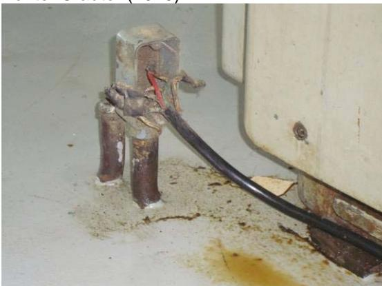
Figura IV. 54 - Ligações inadequadas
