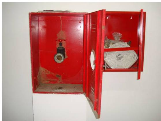
Figura IV. 80 - Caixa de Hidrante
